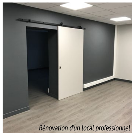
Pose d'un plafond phonique Brasserie La Fontaine
