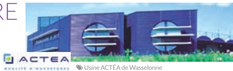
Usine ACTÉA de Wasselonne
